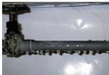
Vlhkost kondenzující na vnějším povrchu potrubního rozvodu stlačeného vzduchu (orosení).
