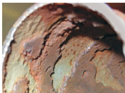
Koroze ve formě rzivých úsad a povlaků
